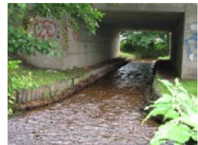
(8) Eine raue Kiesohle und beidseitige Bermen verbessern die Passage unter einer Brücke
