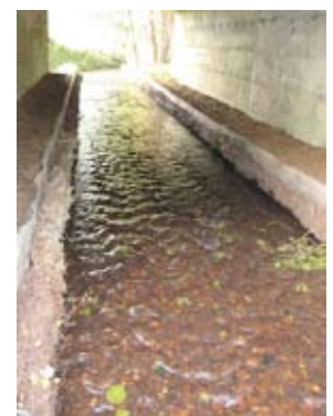
(2) Passierbarkeit für Wasser- und Landorganismen unter der Este-Brücke bei Welle an der B3.
