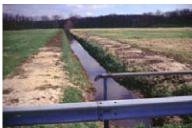
(4) Harte Gewässerunterhaltung, Landnutzung bis ans Ufer heran und fehlende Uferandpflanzen führen zu starker Erosion und Sandeintrag
