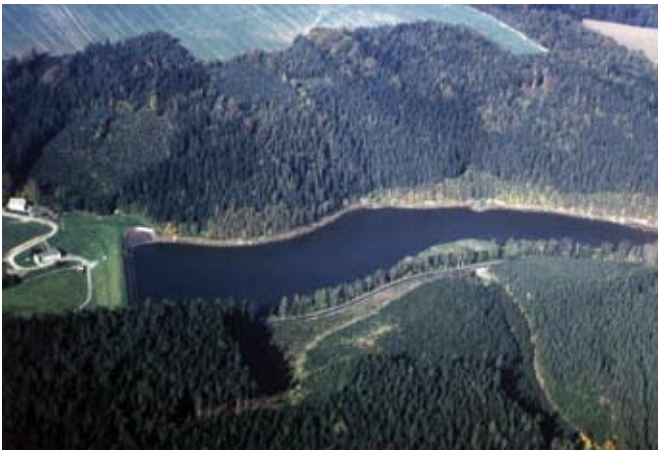
Die Krebsbach-Talsperre ist das erste Beispiel für den Rückbau einer Talsperre in Deutschland. Foto: Thüringer Fernwasserversorgung
