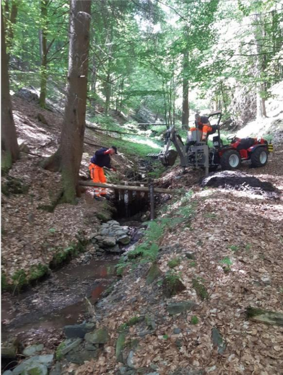
**Abbildung 7: Wartung eines Geschiebefangs an einem Schwarza-Zufluss im Dunkeltal. Foto: GUV 16.**
