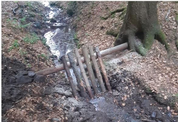
Abbildung 12: Geschiebefang im Dunkeltal nach Instandsetzung 2020. Foto: GUV 16.
