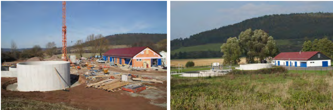
Abbildung 53: Kläranlage Gleisdreieck im Bau und nach der Fertigstellung (Quelle: TLUG)
