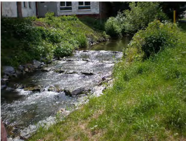
Abbildung 42: naturnahe Sohlgleite (Quelle: TAB)
