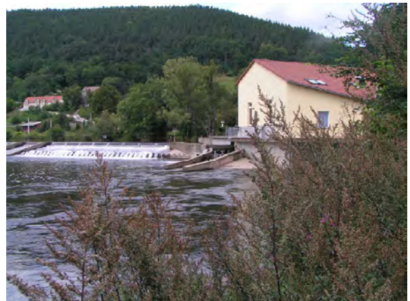
Abbildung 38: Wasserkraftanlage an der Saale in Uhlstädt (Quelle: M. Dittrich, TLUG)
