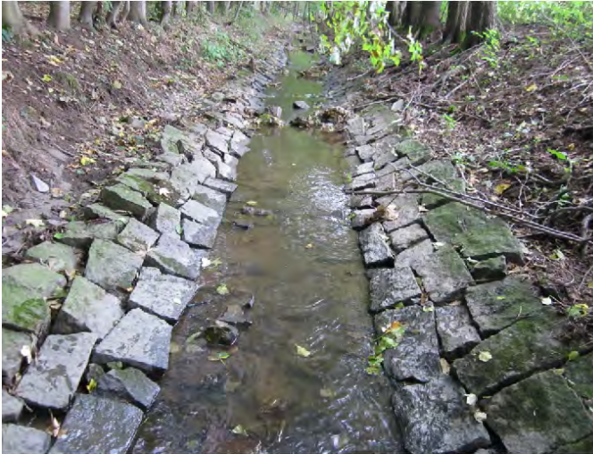
Abbildung 36: „Harter“ Uferverbau an der Lemnitz (links); begradigter Tonndorfbach nach Schellroda (rechts) (Quelle: Fotosammlung TLUG)
